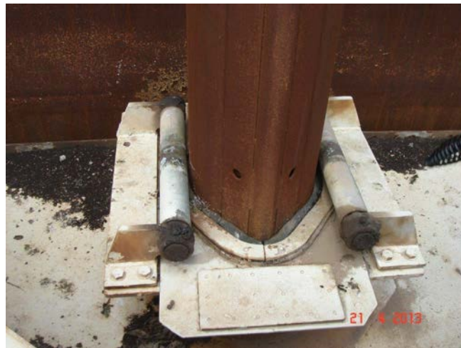
הצינור המוביל נע באמצעות Guide Rollers.
